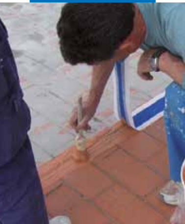
Mozgási hézag vízszigetelése, a helyszínen Aquaflex Roof-be helyezett Mapeband segítségével
