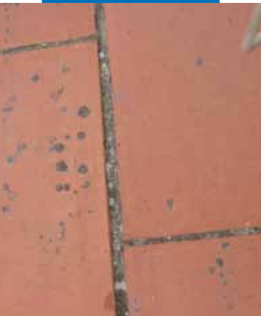
Egy példa régi terracotta padlóra, amely előkészítést igényel Aquaflex Roof felvitelét megelőzően
