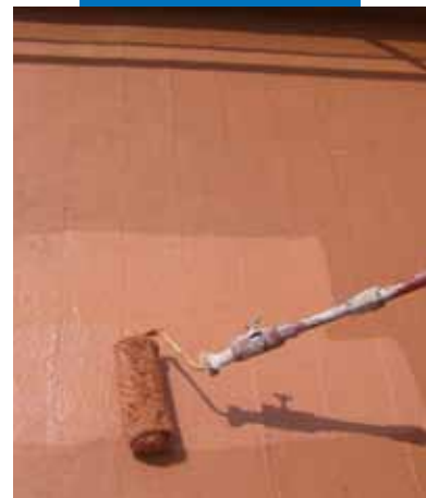
Aquaflex felhordása hosszúszerű hengerrel
