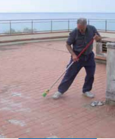
Az alapfelület tisztítása Aquaflex Roof felvitelét megelőzően
