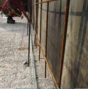
Idrostop B25 fektetése
