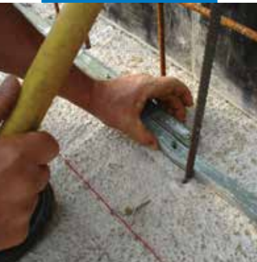
Idrostop B25 rögzítése
