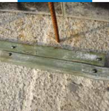
Idrostop B25 végeinek átlapolása
