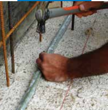
Idrostop B25 rögzítése
