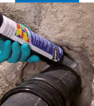
A Mapeproof Swell alkalmazása csővezeték körül
