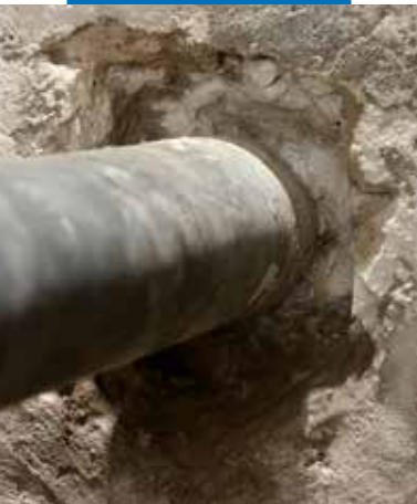
A betonszerkezet bontása csővezeték körül
