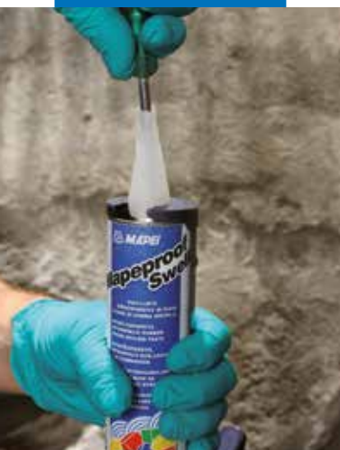
A Mapeproof Swell védőmembránjának kilyukasztása
