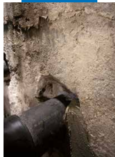
Az alkalmazott Mapeproof Swell fedése Mapegrout T40 -nel
